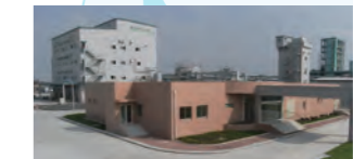
呉羽(常熟)フッ素材料有限公司 工場
