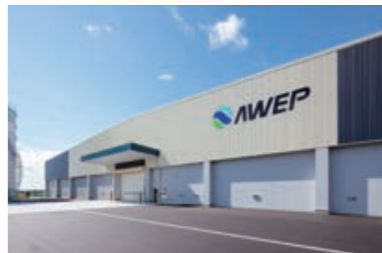
クレハ錦建設株式会社 2020年度施工実績例：AWEP小名浜バイオマス発電事業木質ペレット・PKS保管所
